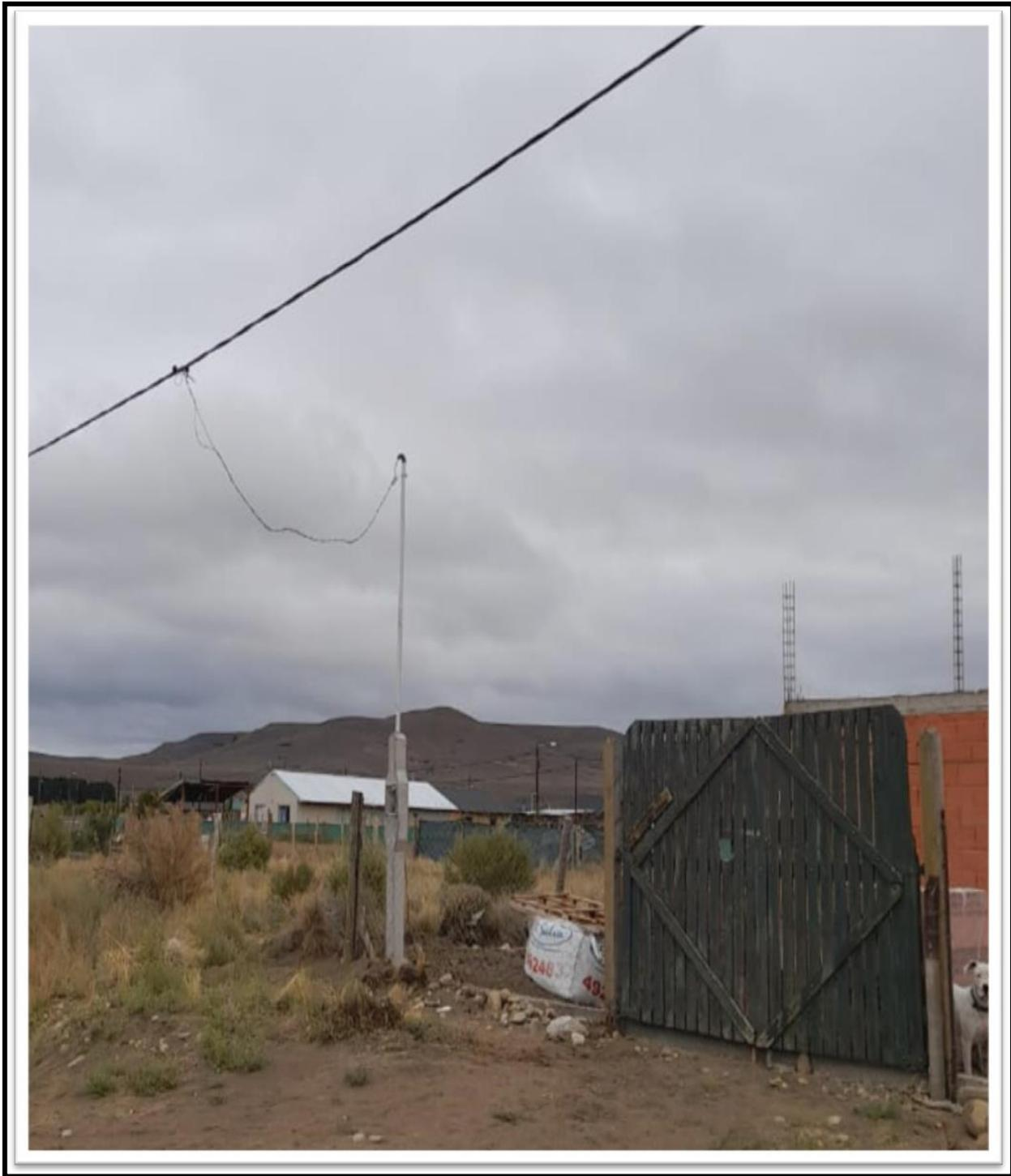
**Imagen 5: Conexión desde línea de distribución a medidor de vivienda particular.**
