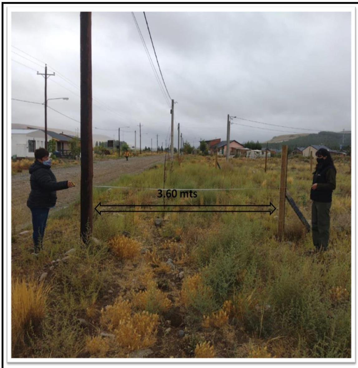
**Imagen 3: Ubicación de poste de distribución de energía eléctrica sobre calle Emprendedores (se puede apreciar el arbolado de alineación a una distancia acorde desde la línea municipal y a 4 mts del poste de luz)**
