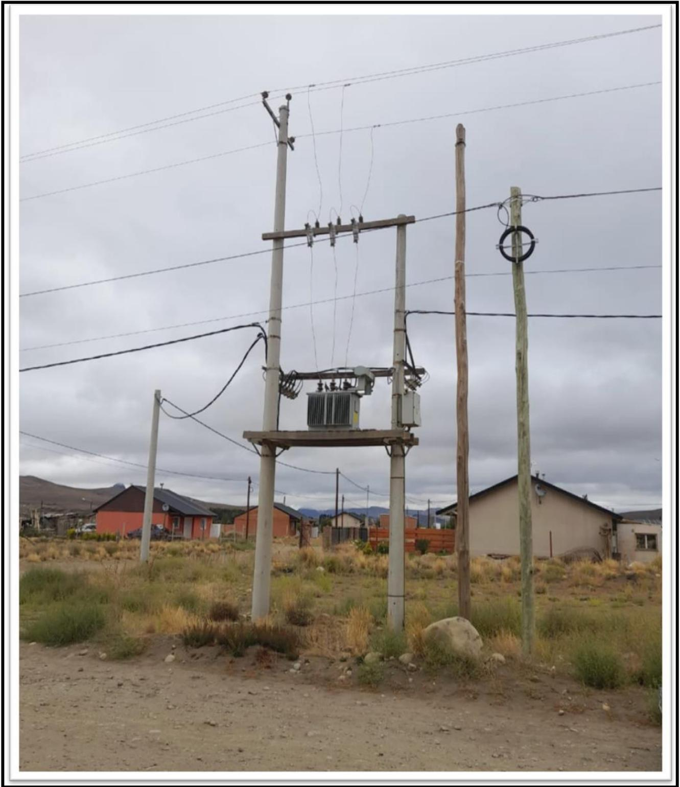
**Imagen 1: Columna de línea de media tensión + transformador para distribución interna**
